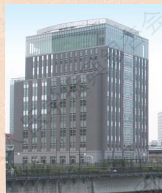
竣工当初の中之島センター
